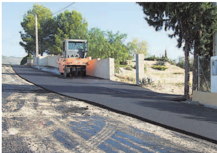
Una máquina trabaja en el camino dels Presos. ■ LP
