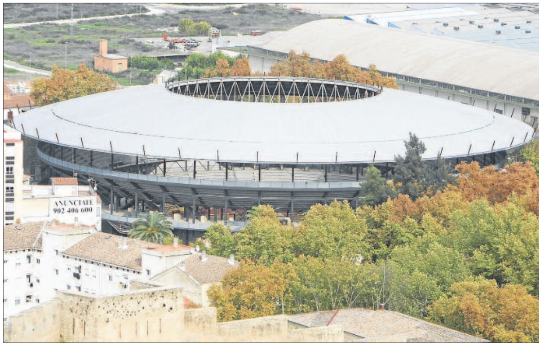
La cubierta de la plaza de toros de Xàtiva, en una imagen de archivo. PERALES IBORRA
